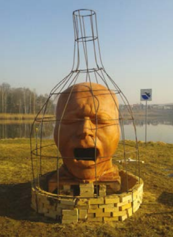
Budowa pieca gazowego do wypału ceramicznej rzeźby, marzec 2015/ fot. Krzysztof Kołodziejski
